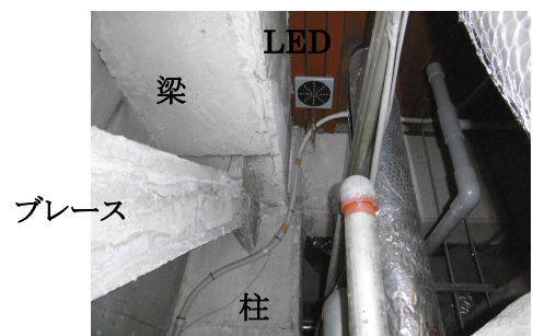
LEDターゲット設置事例(上階床下)
